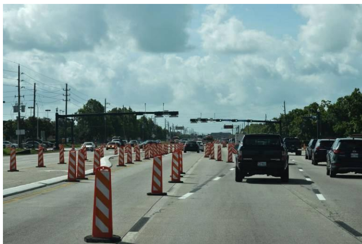
Рис. 8. Ремонт дороги в США.
