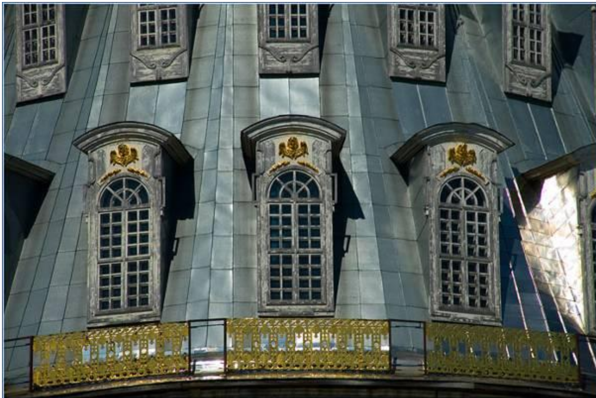
Реставрация крыши собора закончена.
