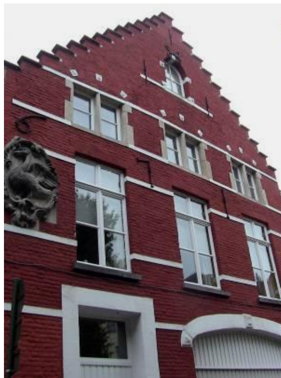
Рис. 4 Декоративная обмазка кирпичной кладки
