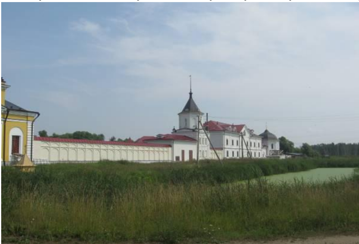
Фото автора 7564. Вид на южные стены Ростовского Троице-Сергиевого Варницкого монастыря
