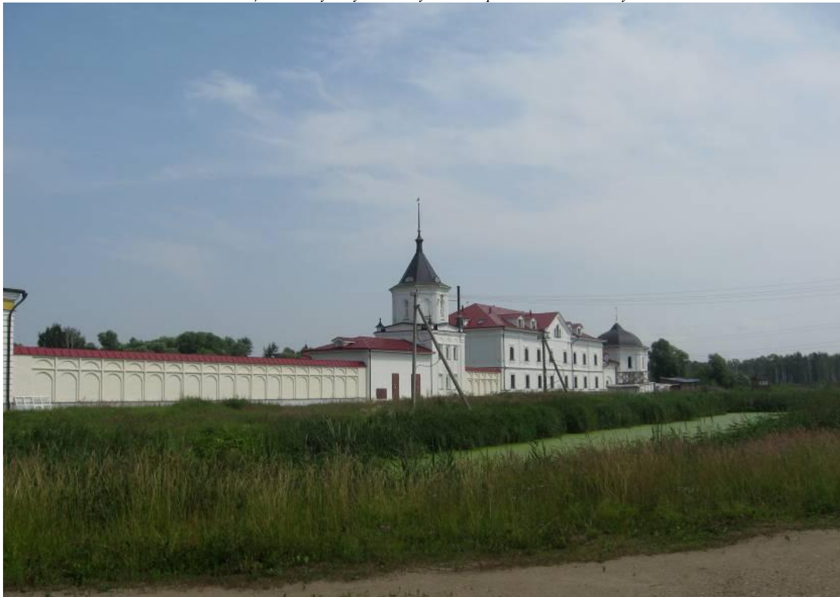
Фото автора 7564. Вид на южные стены Ростовского Троице-Сергиевого Варницкого монастыря
