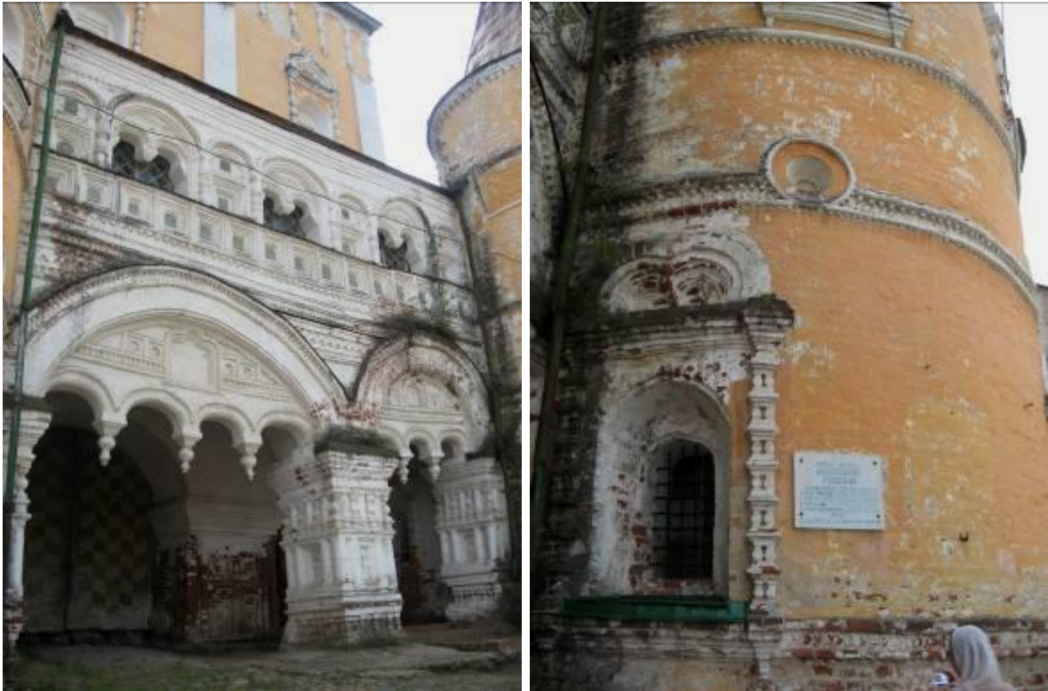
Фото 7647 Кирпичные узоры Сретенской церкви. Фото 7648 Башня с памятной доской о строительстве монастыря
