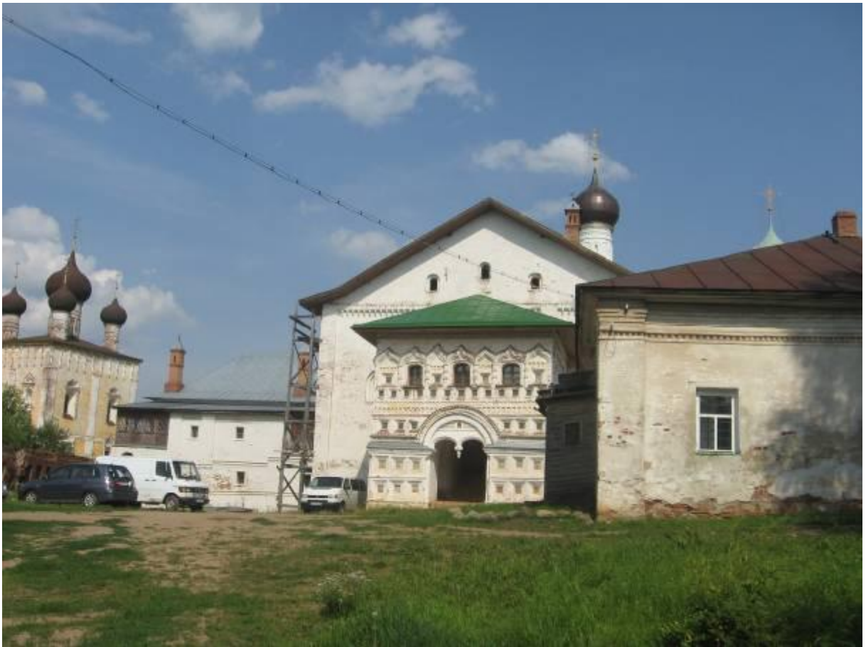
Фото 7798. Западный фасад Благовещенского храма и вид на Сретенскую церковь.
