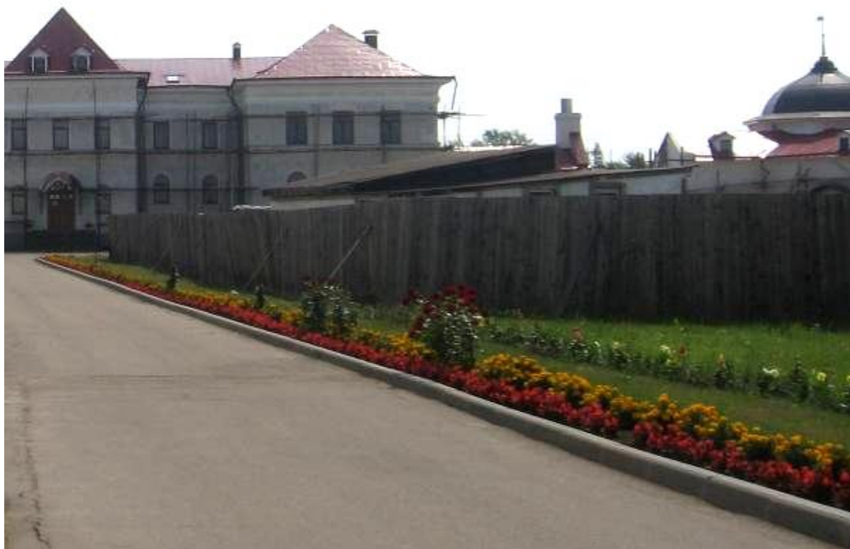
1. Строящийся собор во имя Прп. Сергия Радонежского
