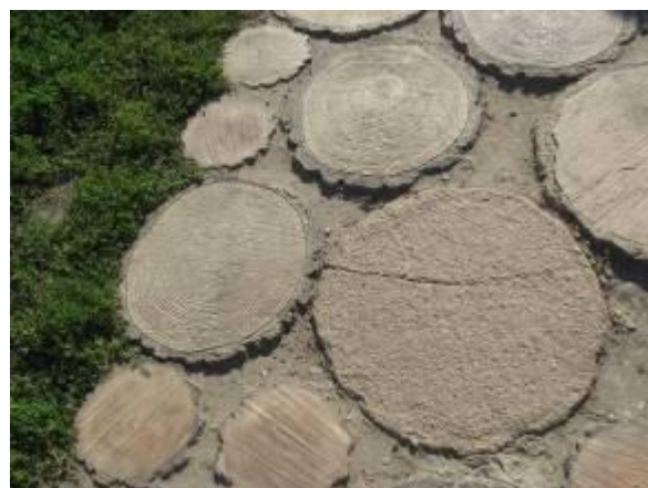
Фото 2555, 2554. Бетонные пешеходные дорожки, стилизованные под спил натурального дерева. Это уже современные технологии!
