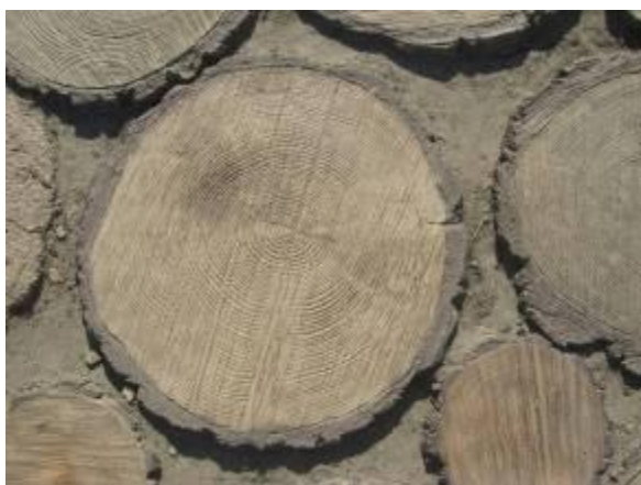
Фото 2555, 2554. Бетонные пешеходные дорожки, стилизованные под спил натурального дерева. Это уже современные технологии!
